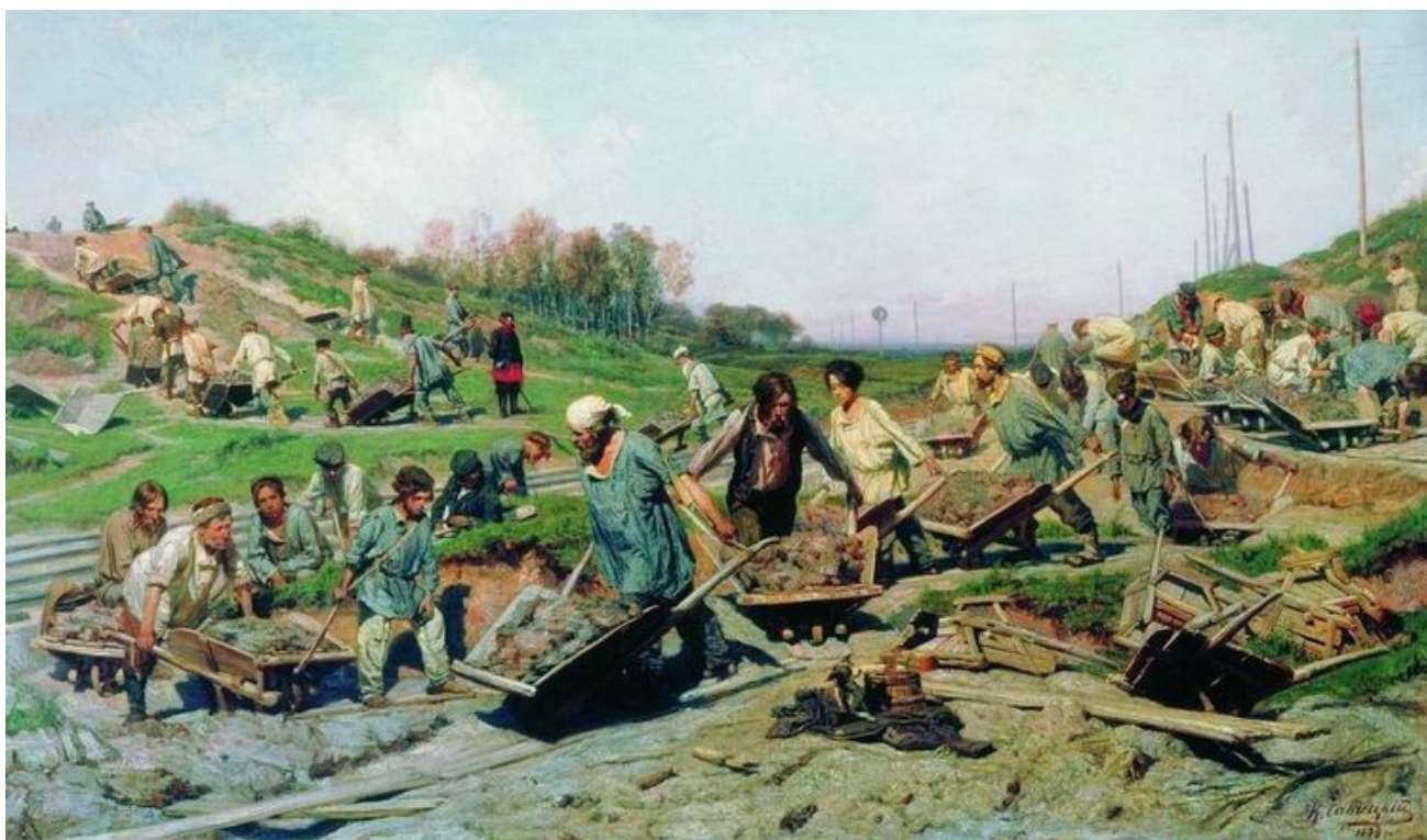
К. Савицкий. Ремонтные работы на железной дороге
