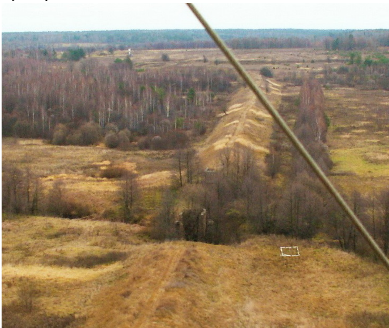
Насыпь недостроенной железной дороги через Мглин в районе д. Хорновка, 2011
